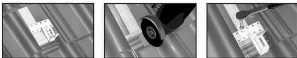
Napelem modulok rögzítése kis dőlésszögű tetőn
