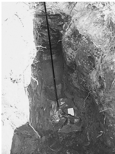
II.5.9a. ábra: Földelő kialakítása kiépítés közben
