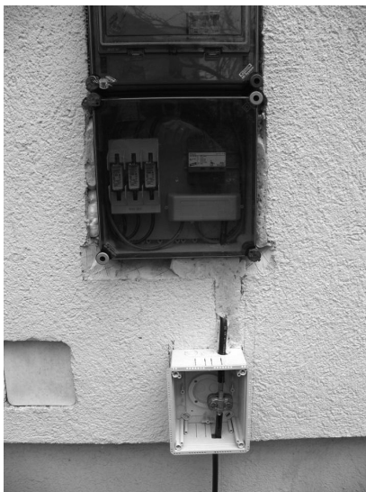
II.5.9b. ábra: Bontható mérési hely kialakítása kiépítés közben
