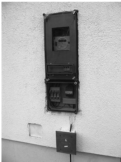
II.5.11. ábra: Fogyasztásmérő hely túlfeszültség-védelmi szekrénnyel, villámvédelmi/potenciálrögzítő földeléssel és bontható mérési hely kialakításával
