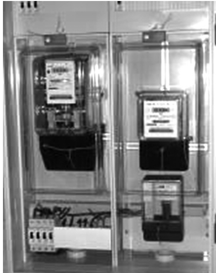
3.3.4. ábra. Falmélyedésbe, falifülkébe elhelyezhető fogyasztásmérő-szekrény szerelés alatt, nyitott ajtóval
