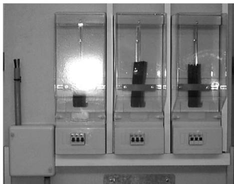
3.3.5. ábra: Elfogadott mérőablák, csoportosan elrendezve
